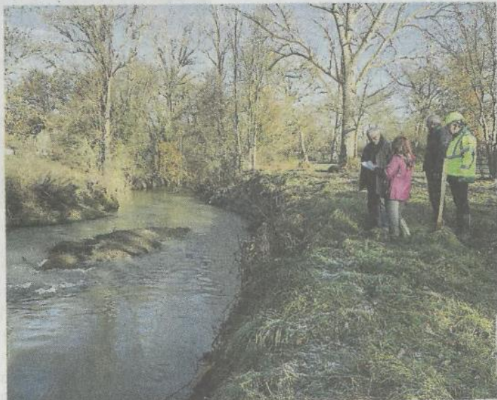
Lors de la visite de chantier au bord du Touch, les représentants de l'entreprise du SM GALT et les élus. /C.C
